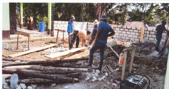
Foto 4: Avance el proyecto de remozamiento
