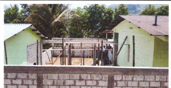
Foto 5: Avance el 50% de la ejecución de remozamiento
