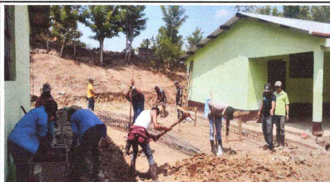
Foto 1: Inicio de ejecución de proyecto de remozamiento
