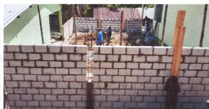
Foto 3: Avance el 30% de la ejecución de remozamiento
