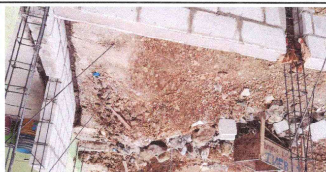
Foto 2: Avance de la ejecución de remozamiento.
